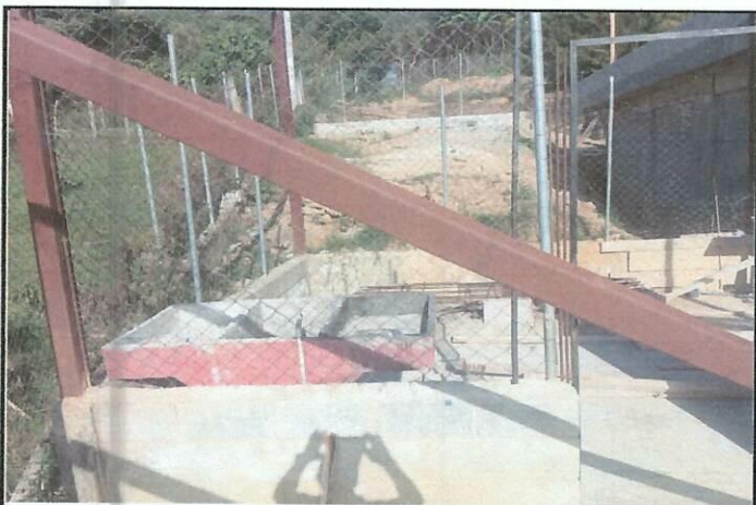
Foto 3: Área donde se contempla el mejoramiento de la estructura tipo pórtico para cocina.
