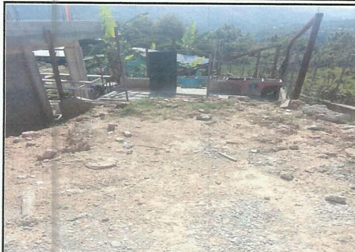
Foto 1: Área donde se contempla el mejoramiento de la estructura tipo pórtico para cocina.
