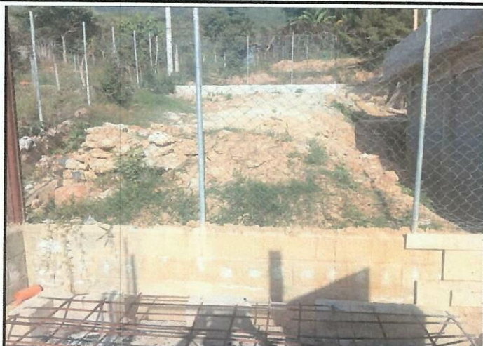
Foto 2: Área donde se contempla el mejoramiento de la estructura tipo pórtico para cocina.
