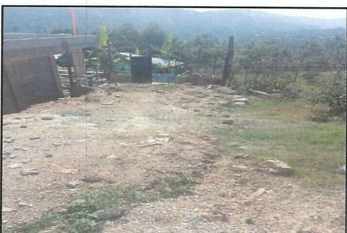
Foto 4: Área donde se contempla el mejoramiento de la estructura tipo pórtico para cocina.
